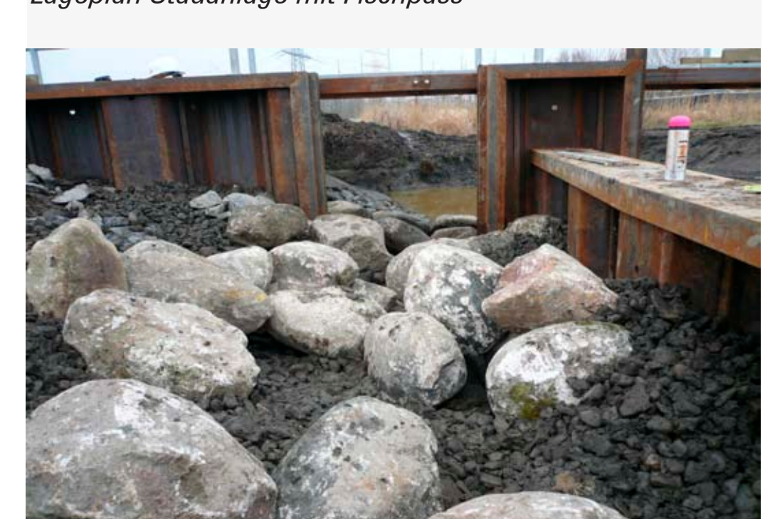
Herstellung differenzierter Strömungsverhältnisse im Fischpass mit Naturbausteinen
