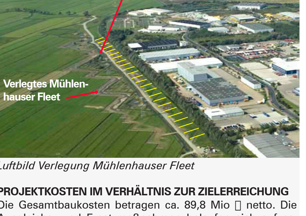
Luftbild Verlegung Mühlenhauser Fleet
