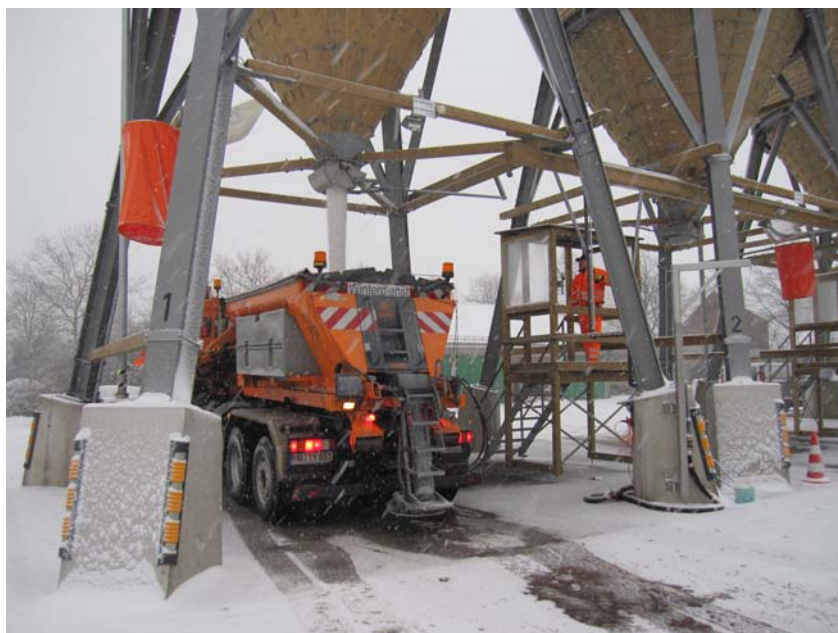
Salzsilos im Einsatz
