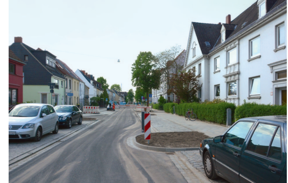
Nach der Umgestaltung – wie im ersten Abschnitt bereits fertiggestellt: Breitere, barrierefreie Gehwege, deutlich abgegrenzte Parkstreifen, ausreichend Platz für Baumpflanzungen
