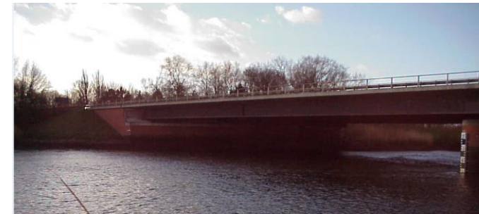
Abbildungen: Seitenansichten Lesumbrücke
