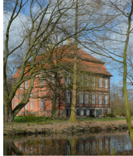
Die Wände der Brücke werden, farblich passend zum Schönebecker Schloss, mit einem Mauerziegel verblendet.
