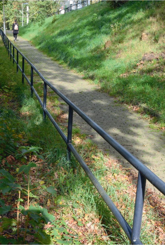
Heute: Zur Straßenbahn- haltestelle führen steile Rampen, die nicht barrierefrei sind.
