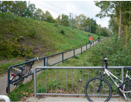
Heute: Fahrräder parken an den Geländern und behindern den Durchgang.
