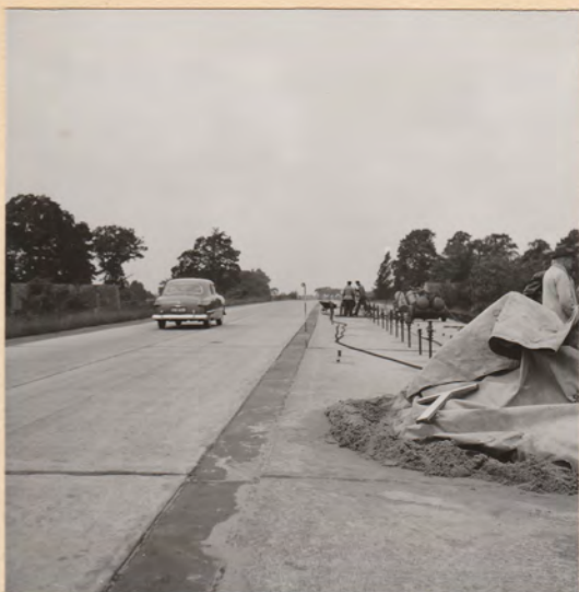
Hebung der Fahrbahnplatten auf pneumatischem Wege
