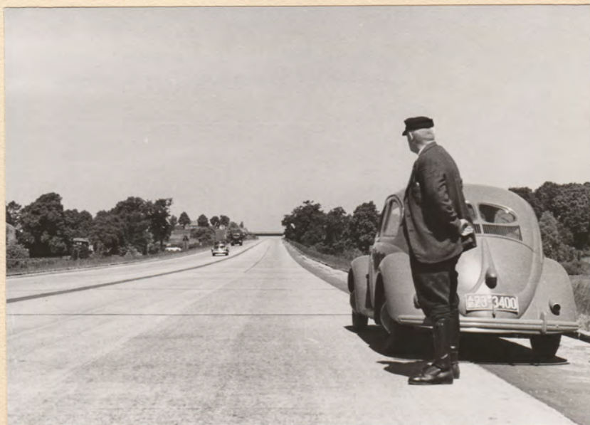
Die Autobahn erfordert ständige Überwachung und Instandhaltung
