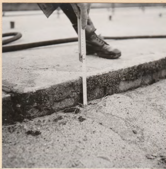
Fahrbahnplatte 13 cm gehoben
