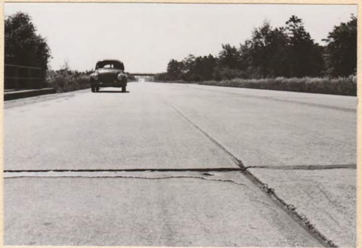
Versackte Fahrbahnplatten
