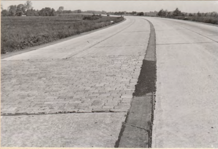
Provisorisch gepflasterte Schadenstellen
