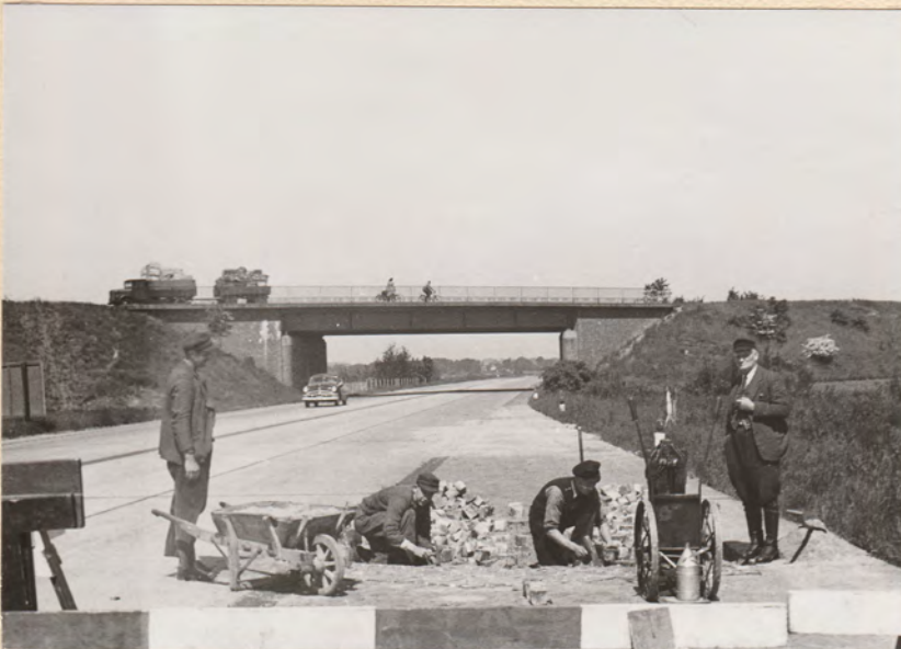
Behebung von Versackungen im Kleinpflaster der Abfahrten
