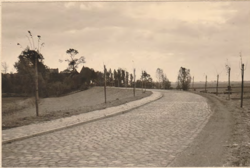
Hasenbürener Landstr. Landstr. II. Ordng. Nr. 9 Umpflasterung von 400 m Sandsteingroßpflaster Fahrbahnbreite 4,50 m Gesamtbreite ~ 7,50 m Fertiggestellt April 1951 Kosten DM 16000
