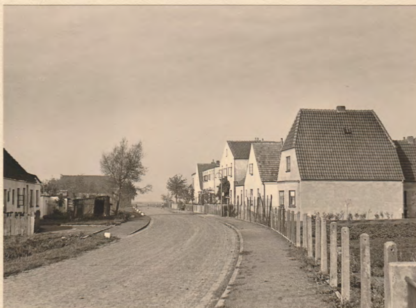
Panzenlaake in Arsten Neupflasterung. Fahrbahnbreite 5,50 m Gesamtbreite 9,00 m Ausbaulänge 400 m altes Basaltkleinpflaster. Fertiggestellt Dez. 1951 Kosten DM 25000
