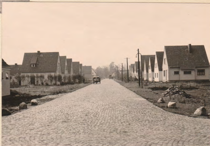
Kirchweyher Weg, Emtinghauser Weg Schwarmer Weg Neubau von drei Siedlungsstraßen in Kattenturm. Fahrbahnbreite 6,00 m Gesamtbreite 10,00 m. Ausbaulänge 585 m altes Basaltkleinpflaster. Fertiggest. Dez. 1951 Kosten DM 61048
