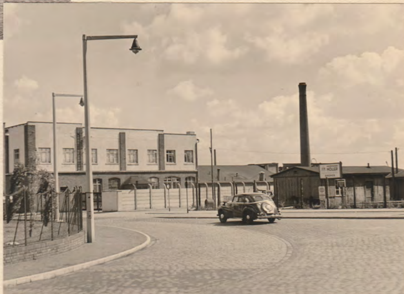
Die Einmündung in die Föhrenstr. wurde erheblich verbreitert. Es wurden 688,2 qm Granitgroßpflaster umgelegt u. vergossen, sowie ein Radweg neu angelegt. Fertiggestellt Sept. 1951 Kosten DM 23892
