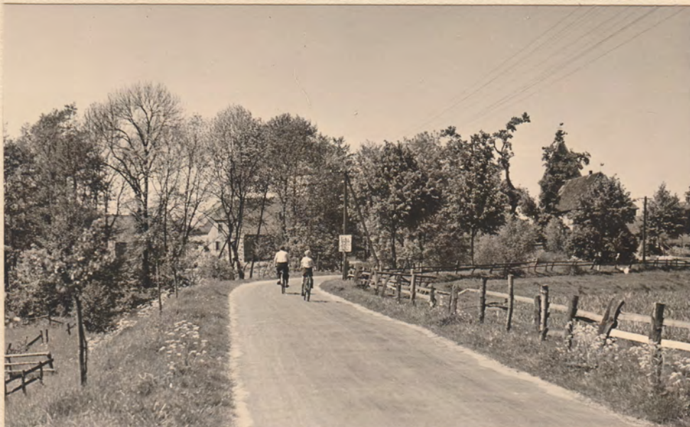
Blocklander Landstr. Landstr. II. Ordng. Nr. 1 Ausbesserungsarbeiten zwischen Ritterhuder Heerstr. u. Entwässerungs- anstalt Wasserhorst ~ 2,3 km Fahrbahnbreite ~ 3,50 m. Oberflächen- behandlung der stark beschädigten Teertränkdecke. Fertiggestellt Aug. 1951 Kosten DM 2000
