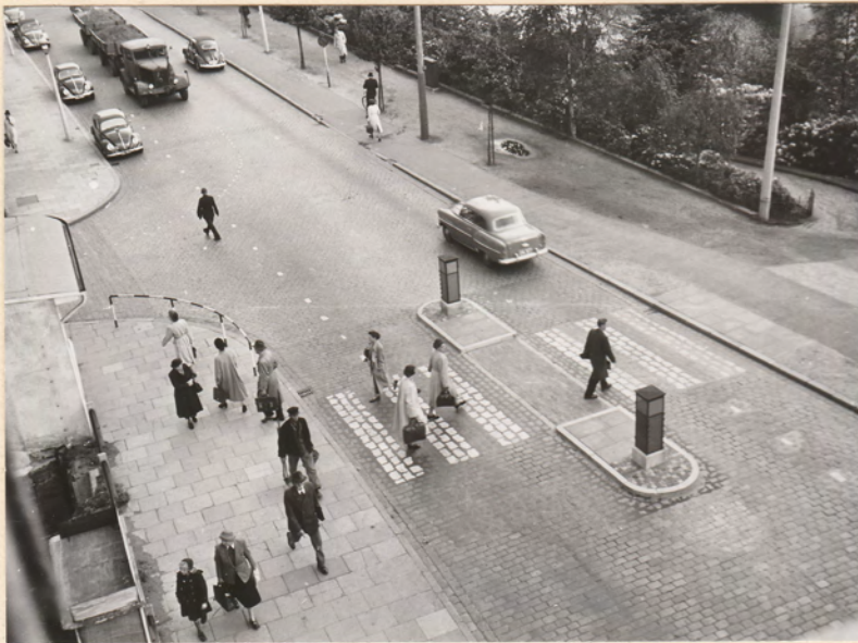
Gehwegübergang Am Wall beim Bischofsnadel. Fertiggest. Mrz. 53
