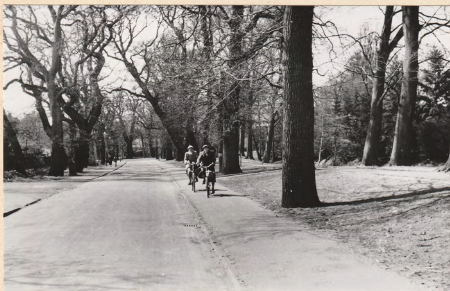
Wiederherstellung. Radwegbreite 1,8 m. Ausbaulänge 480 m Teersplitt. Fertiggestellt Mai 1952. Kosten: DM
