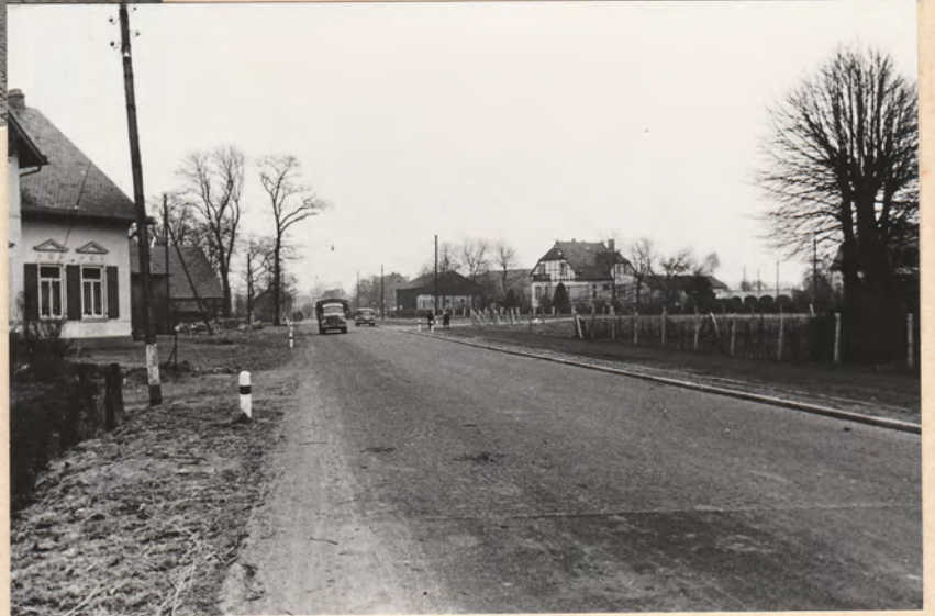
Kurvenbegradigung der Mahndorfer Heerstr. Fahrbahnverbreiterung von 5 auf 6 m Gesamtbreite 15 m (Radweg in Teertränkung) Granitkleinpflaster Fertiggestellt April 1953 Kosten: DM 75 499,79
