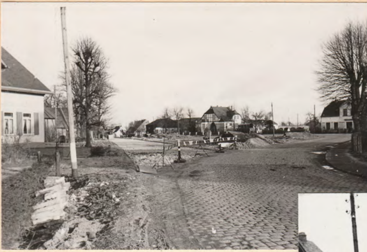
Kurvenbegradigung der Mahndorfer Heerstr. Fahrbahnverbreiterung von 5 auf 6 m Gesamtbreite 15 m (Radweg in Teertränkung) Granitkleinpflaster Fertiggestellt April 1953 Kosten: DM 75 499,79
