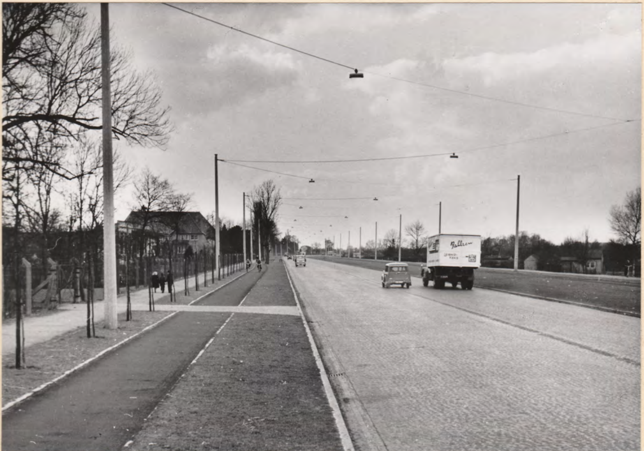
Neuenlander Str., neue Ortsdurchfahrt der Bundesstr. 6
