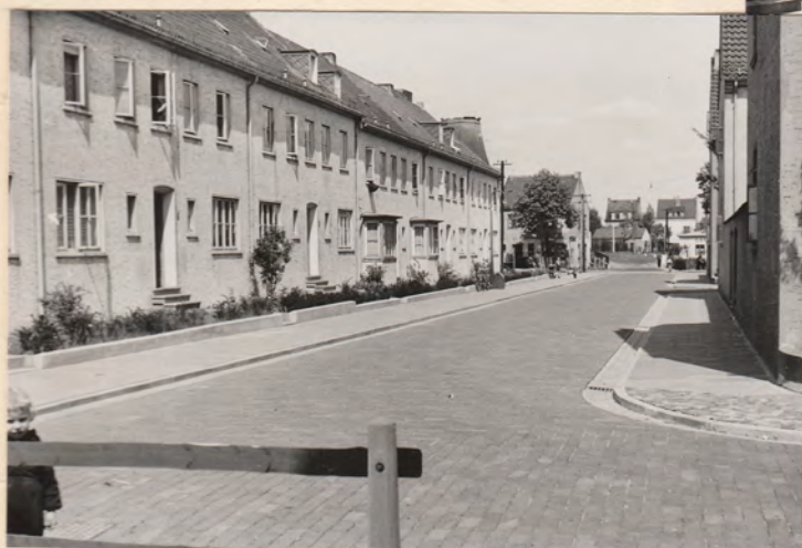
Luchtbergstr. u. Auf der Lucht Neuanlage. Fahrbahnbreite 5-6 m Gesamtbreite 8-10 m. Ausbaulänge 380 m. Heisterholzer Klinker flach Fertiggestellt März 1953 Kosten: DM 13 378
