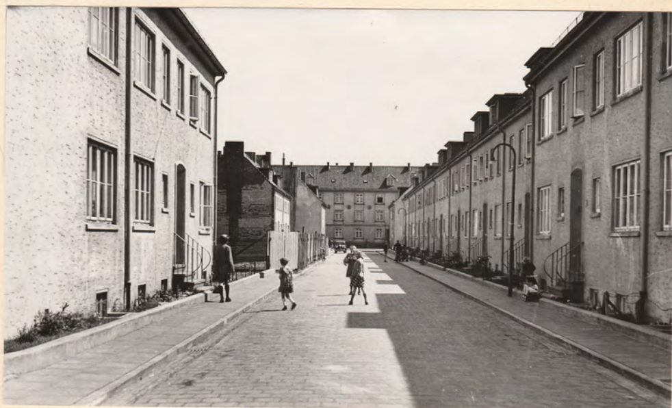
Neuanlage. Fahrbahnbreite ~6,0 m. Gesamtbreite 8 u. 10 m Ausbaulänge 143 m. Betonpflaster mit u. ohne Fugenverguß Fertiggestellt April 1953 Kosten: DM 6181
