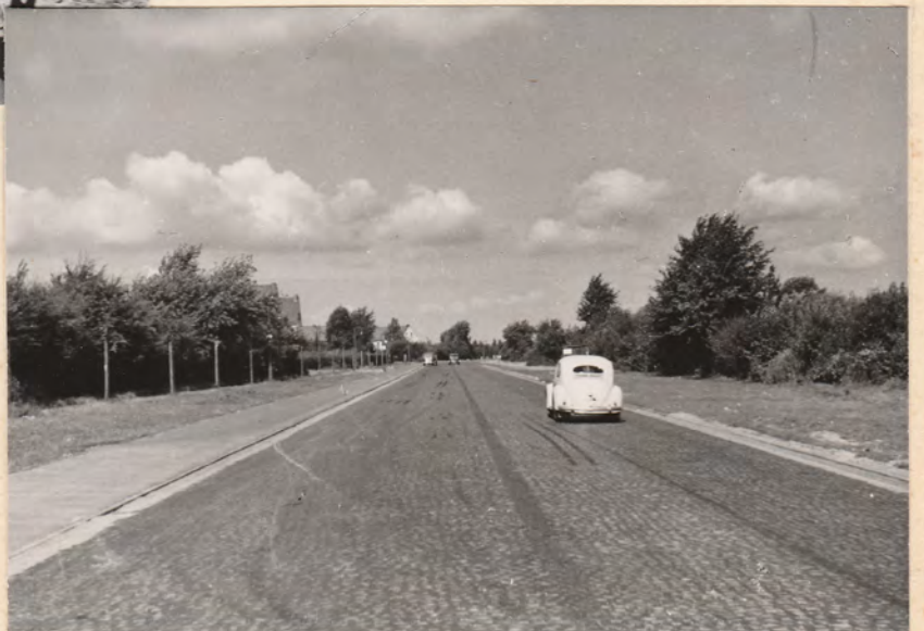
Ritterhuder Heerstr. Umpflasterung. Fahrbahnbreite 9 m Gesamtbreite 18 m. Ausbaulänge 480 m Granitkleinpflaster. Fertiggest. Sept. 53 Kosten: DM 91600
