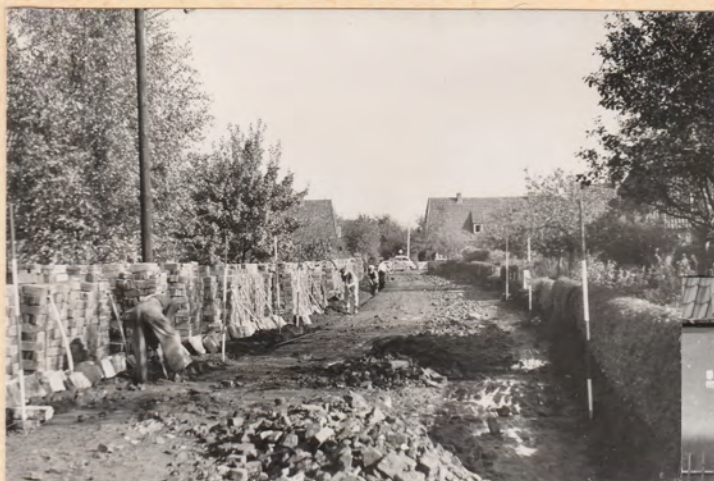
Grolland Siedlung, Tom-Dyk-Str. Neuausbau. Fahrbahnbreite 5,0 m Gesamtbreite 7,5 m Bockhorner Klinker hochk. Fertiggestellt März 1953 Kosten: DM siehe Seite 29 Ausbaulänge: Tom-Dyk-Str., Vehrels und Huntorpstr. 2430 m
