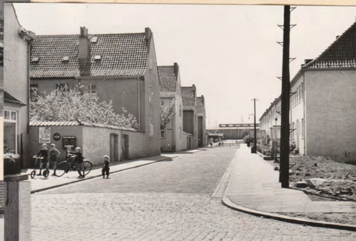
Luchtbergstr. u. Auf der Lucht Neuanlage. Fahrbahnbreite 5-6 m Gesamtbreite 8-10 m. Ausbaulänge 380 m. Heisterholzer Klinker flach Fertiggestellt März 1953 Kosten: DM 13 378
