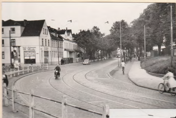
Von Esmarchstr. bis zur Bahn-Unterführung Fahrbahnverbreiterung von 10,0m auf 12,0m 2 Radwege à 1,50m breit, mit Teertränkdecke - Granitgroßpflaster mit Fugenverguß. Fertiggestellt Dez. 1952 Kosten: DM siehe Seite 70
