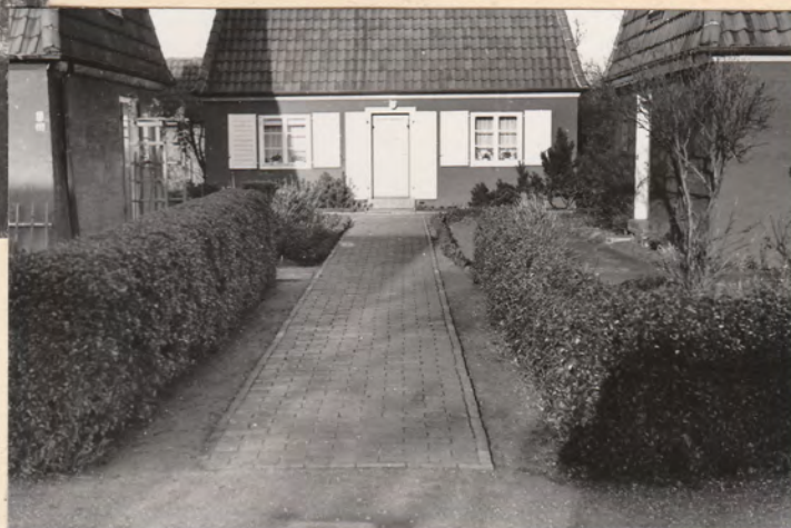
Grolland Siedlung, Tom-Dyk-Str. Neuausbau. Fahrbahnbreite 5,0 m Gesamtbreite 7,5 m Bockhorner Klinker hochk. Fertiggestellt März 1953 Kosten: DM siehe Seite 29 Ausbaulänge: Tom-Dyk-Str., Vehrels und Huntorpstr. 2430 m
