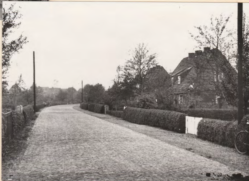
Tom-Dyk-Str., alter und neuer Zustand
