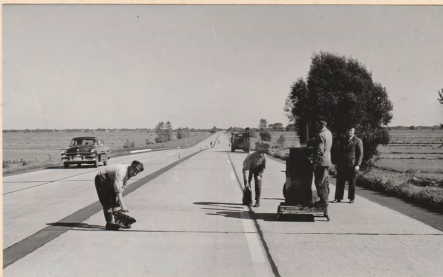
Die Wiederherstellungsarbeiten an der Bundes-Autobahn wurden fortgesetzt. Versackte Platten wurden gehoben, bis zu 14 cm. Fugen gereinigt und neu vergossen. Kosten: DM 126 632,88
