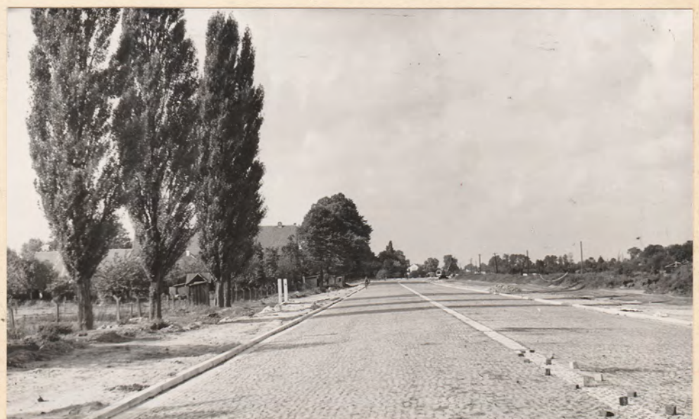
Baustelle zwischen Kirchweg und Vohnenstr.
