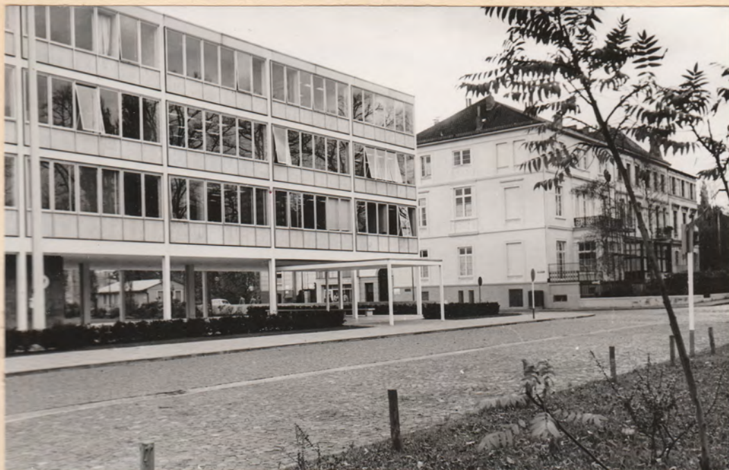
Neuanlage einer Zufahrt mit Parkplatz, zum Amerik. Generalkonsulat Fahrbahnbreite 6 m. Gesamtbreite 9 m. Ausbaulänge 70 m. Granit- und Quarzporphyr- Kleinpflaster, Fertiggestellt Jan. 1954 Kosten : DM 28.780
