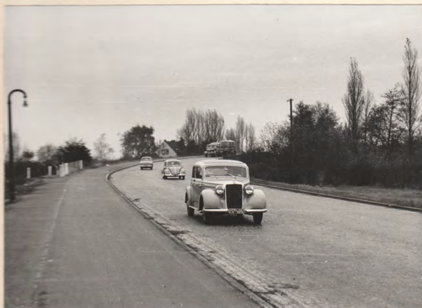
Hastedter Heerstr. Fahrbahnverbreiterung von 10 m auf 12 m Gesamtbreite 21 m. Ausbaulänge 510 m. Granitgroßpflaster 2 Radwege, je 2 m breit, mit Asphaltfeinbetondecke. Fertiggest. Nov. 1953 Kosten: DM 87600
