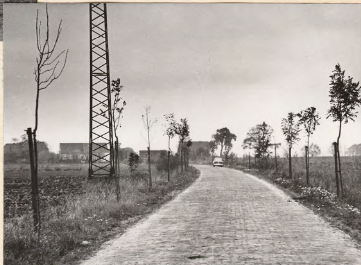
Brokhuchtinger Landstr. Umpflasterung. Fahrbahnbreite 5 m Umgepflasterte Strecke 606 m Bockhorner Klinker hochkant. Fertiggestellt Juli 1953 Kosten: DM 14 556
