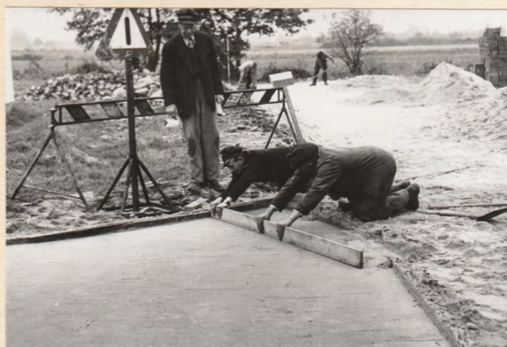
Neubau von Siedlungsstraßen beim Hohenhorster Weg
