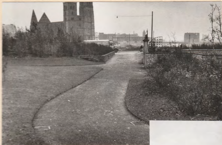
Anlage einer Schwerlaststraße zum Hafengebiet
