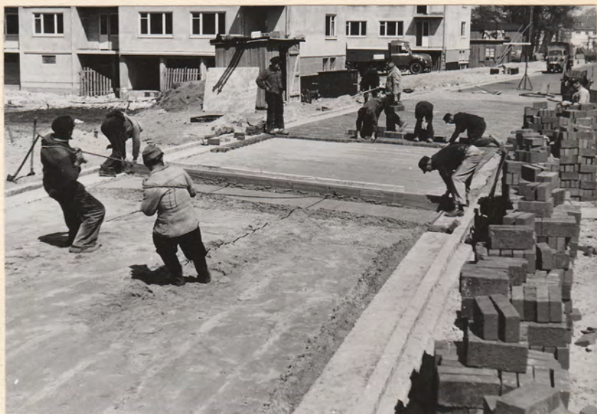
Abziehen der verdichteten Bettung mit einer Profilbohle
