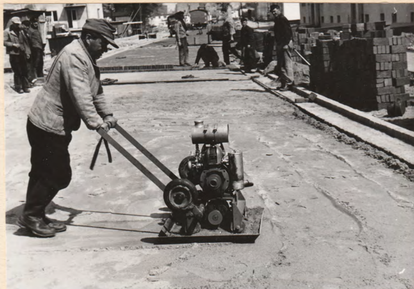
Verdichten der Bettung mittels Rüttelplatte
