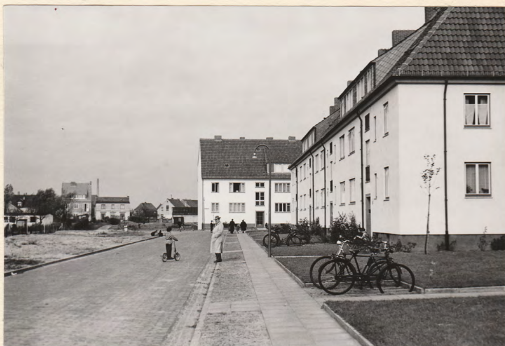
Wohnstr. beim Osterhop Neuanlage der Drill- und Sensenstr. Fahrbahnbreite 6 m. Gesamtbreite 10 m. Ausbaulänge 228 m. Heisterholzer Klinker flach. Fertiggestellt November 1954 Kosten: DM 40 462
