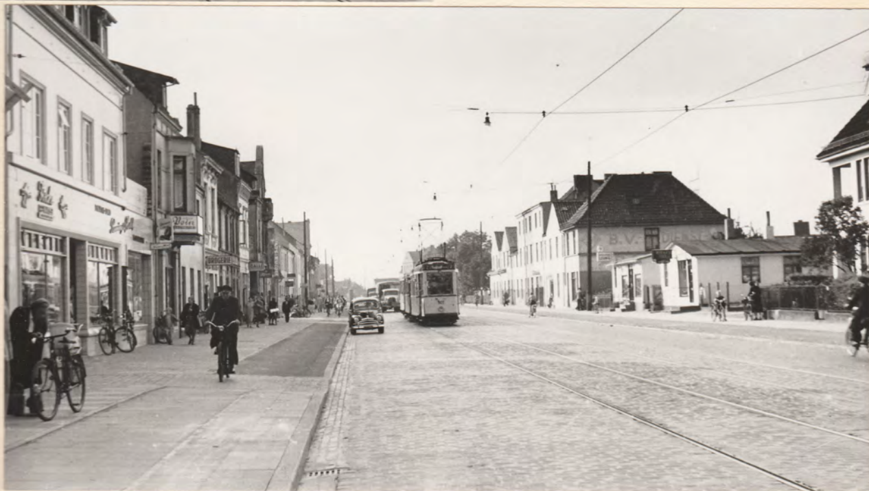
Hastedter Heerstr. Fahrbahnverbreiterung von 10 m auf 12 m Gesamtbreite 21 m. Ausbaulänge 510 m. Granitgroßpflaster 2 Radwege, je 2 m breit, mit Asphaltfeinbetondecke. Fertiggest. Nov. 1953 Kosten: DM 87600
