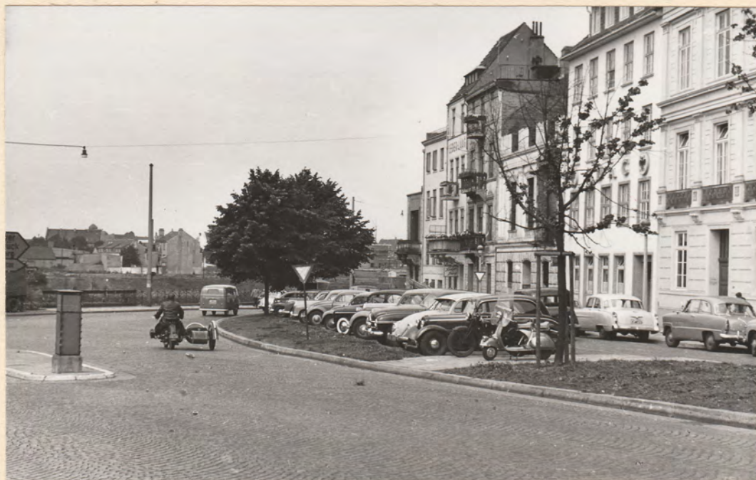
Herstellen eines Parkplatzes am Alten Wall für 15 Pkw. Ausbaulänge 37,5 m Granitkleinpflaster. Fertiggestellt Apr. 1953. Kosten : DM 1300
