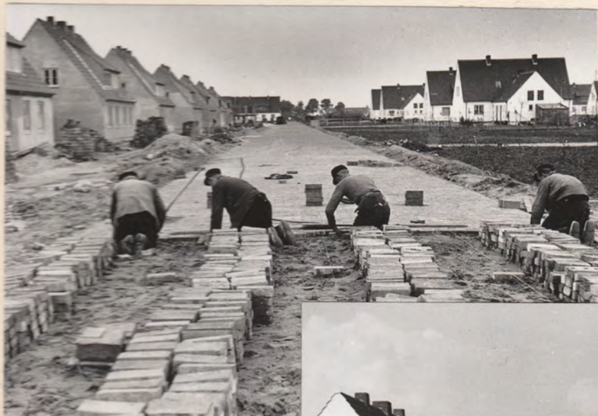
Neuanlage von vier Siedlungsstraßen Fahrbahnbreite 6 m. Gesamtbreite 11 m Ausbaulänge 1350 m. Heisterholzer Klinker flach, auf Unterbau. Fertiggestellt
