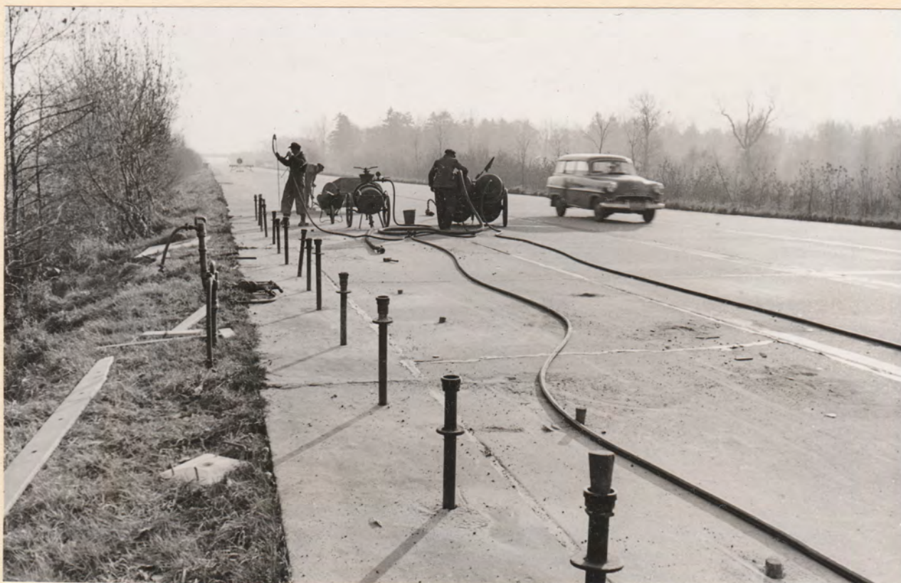
Die Unterhaltung der Autobahn wurde fortgesetzt, versackte Fahrbahnplatten gehoben und Fugen neu vergossen. Kosten: DM 186372,-
