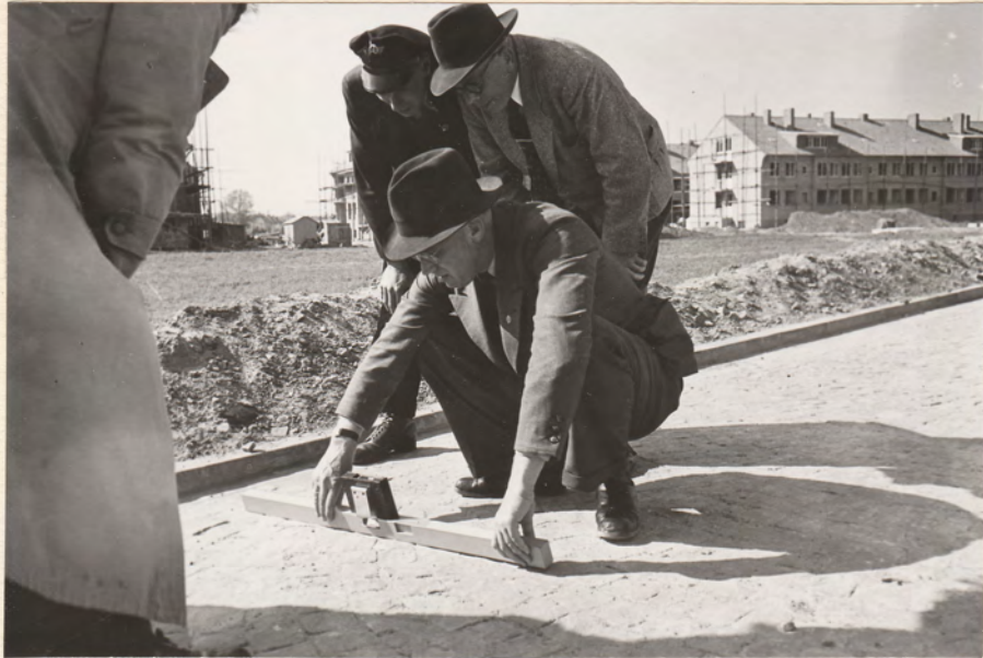
Vorgeschriebene Ebenflächigkeit und Gefällverhältnisse der Straßendecke werden nachgeprüft.
