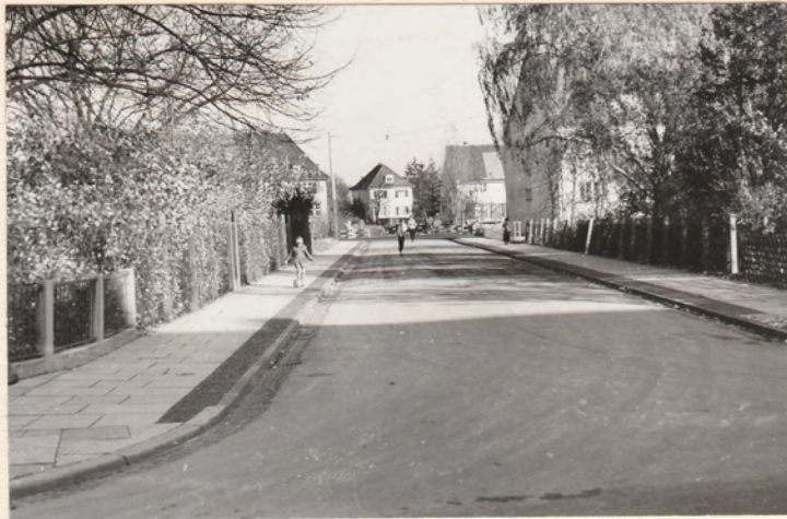
Charlottenburger Str., Ausbau wie Emil-Trinkler-Str. Neuanlage 87m lang. Fertiggestellt Sept. 1953
