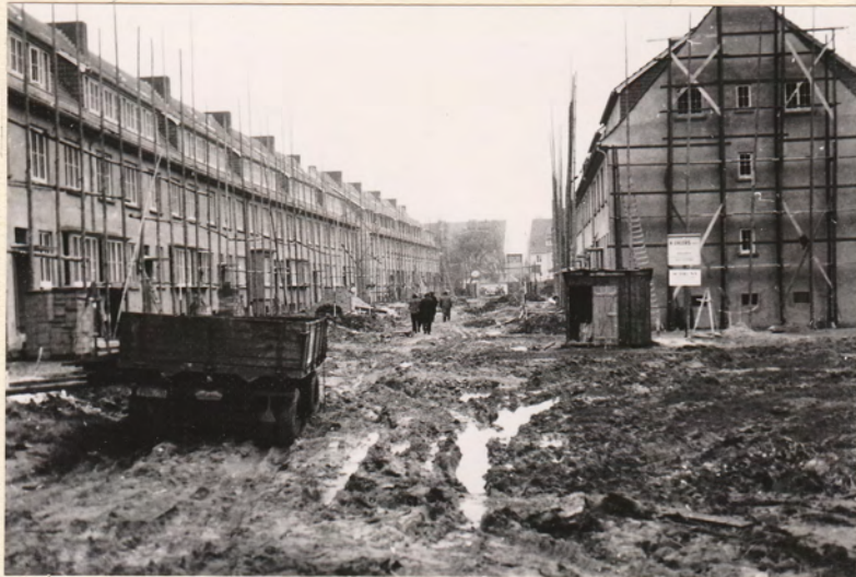
Hauptm.-Böse-Weg, vor dem Ausbau
