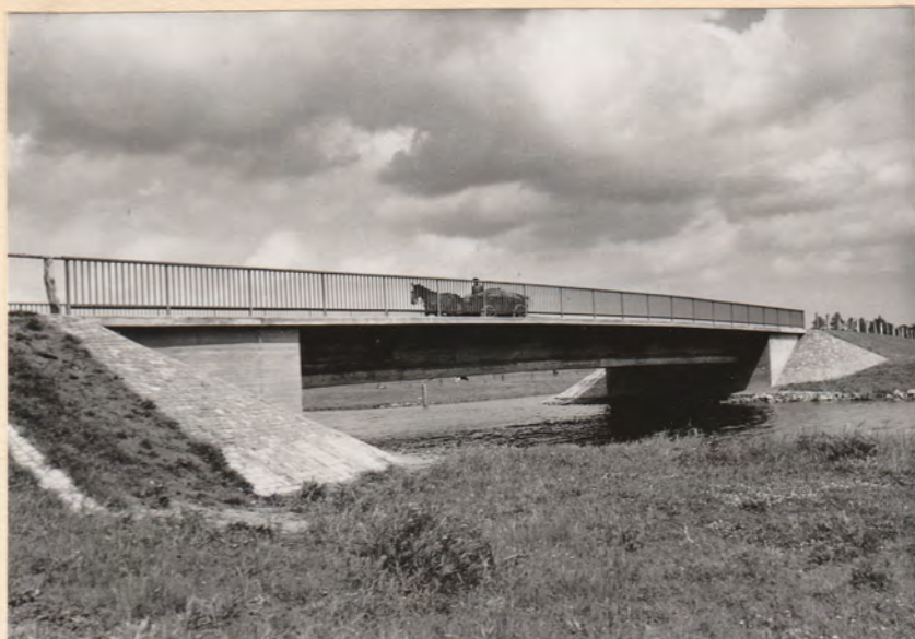
Brücke an der Borgfelder Landstr.
