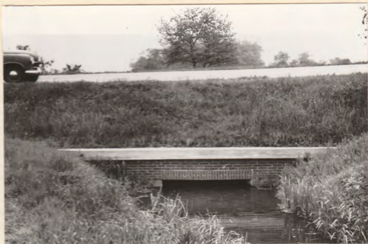
Autobahndurchlaß bei km 123,779
