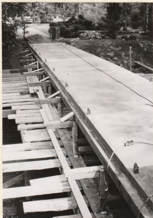
Brücke zwisch. Feld L u. M Stützweite 5,36 · 6,30 · 5,36 m Gesamtbr. 1,78 m Tragfähigkt. 500 kg/m 2 Betonplatte auf I P 16 Kosten: DM 13 300,-
