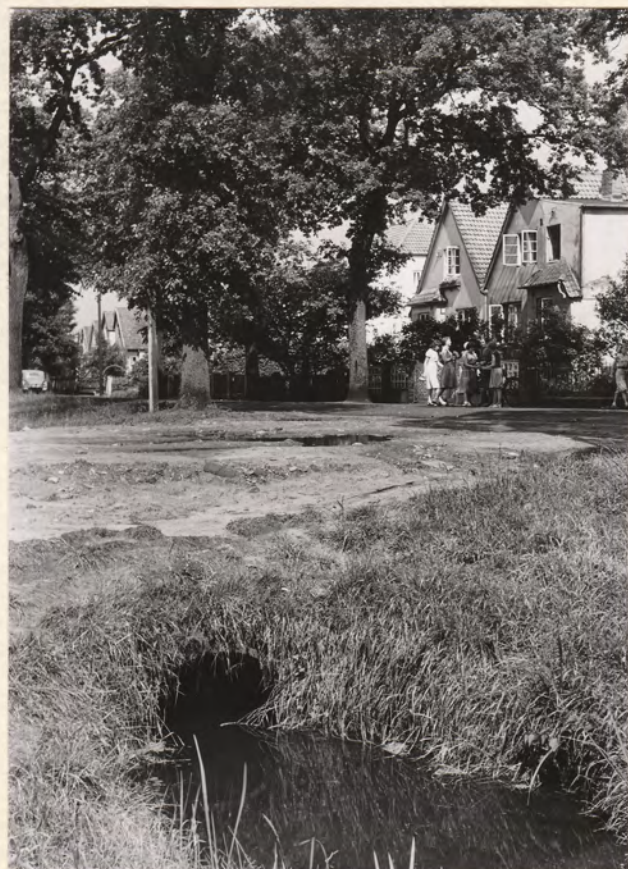
Rohrdurchlaß an der Alten Heerstr. in Huchting
