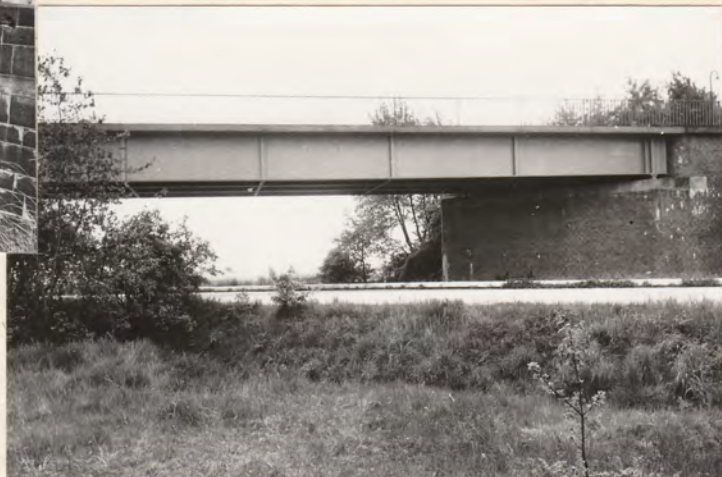
Anstricharbeiten an der Brücke über die Autobahn im Zuge der Marcusallee Kosten: DM 2800,-
