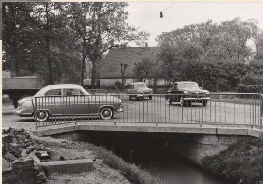
Brücke über das Vahrer Fleet Vahrer Str. - Schneeverdinger Str. Stützweite 3,65 m Gesamtbr. 18,95 m Tragfähigkeit: Klasse 30 Stahlbeton Kosten: DM 28 000,-
