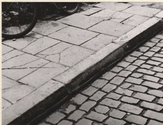
neuer Zust. mit Betonblombe
