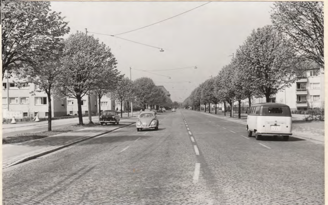
Zwisch. St. Jürgenstr. u. Friedr.-Karl-Str., Ortsfahrbahn 4,5 m breit in Teerschotter ausgebessert. Radweg 1,53 m br. bituminöse Decke. Zwisch. Friedr.-Karl-Str. u. Bennigsenstr. Radwege: Nords. 2 m br., Süds. 2,53 m br. bitum. Decke, Kalteinbau 50 kg./m 2 auf 10-15 cm stark. Unterbau aus Plattenbr. u. Lavaschlacke. Teilstr. in Heisterholzer- u. Bockhorn. Klinker flach ohne Unterbau. Fertiggestellt Aug. 55 Kosten: DM 609 355.-
