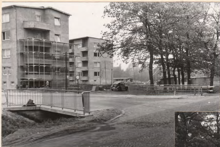
Brücke über das Vahrer Fleet Vahrer Str. - Schneeverdinger Str. Stützweite 3,65 m Gesamtbr. 18,95 m Tragfähigkeit: Klasse 30 Stahlbeton Kosten: DM 28 000,-
