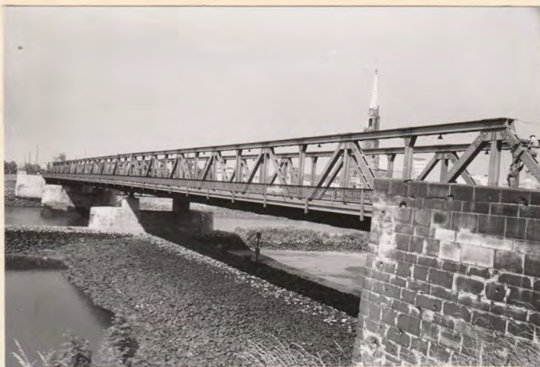
Anstricharbeiten an der Stephanibrücke Kosten: DM 44974,-
