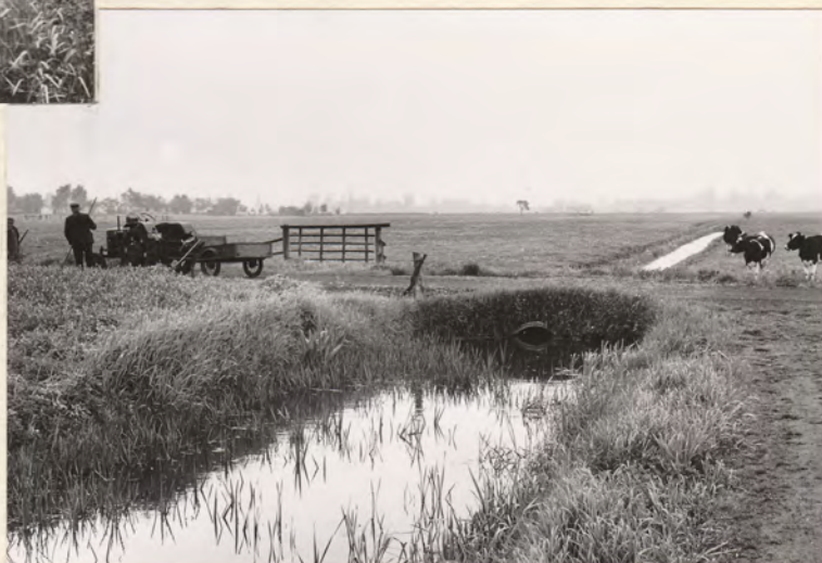
Rohrdurchlaß im Seitenweg der Autobahn bei km 123,779
