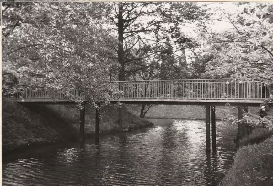
Brücke zwisch. Feld L u. M Stützweite 5,36 · 6,30 · 5,36 m Gesamtbr. 1,78 m Tragfähigkt. 500 kg/m 2 Betonplatte auf I P 16 Kosten: DM 13 300,-
