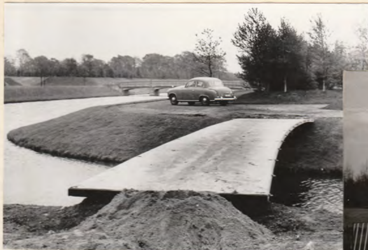
Brücke westlich Feld W Stützweite 13,40 m Gesamtbr. 2,60 m Tragfähigkeit 3 t. Stahlbeton Kosten: DM 16600,-
