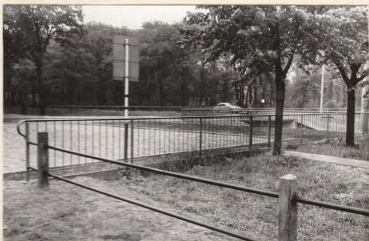
Neues Eisengeländer am Torfkanal Kosten: DM 10000,-
