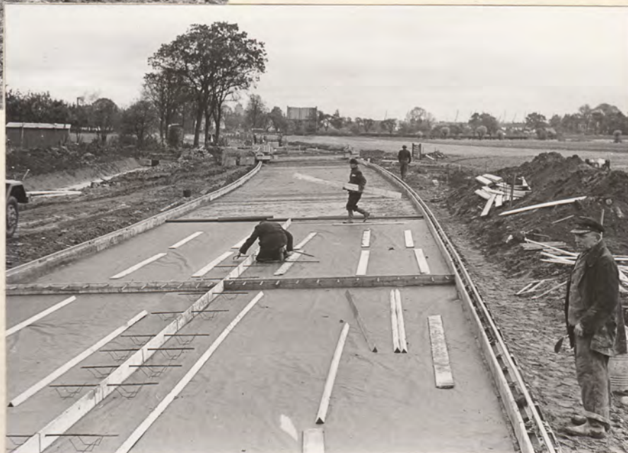
Legen der Bohlen mit Schienen und herstellen des Planums durch Verteiler
