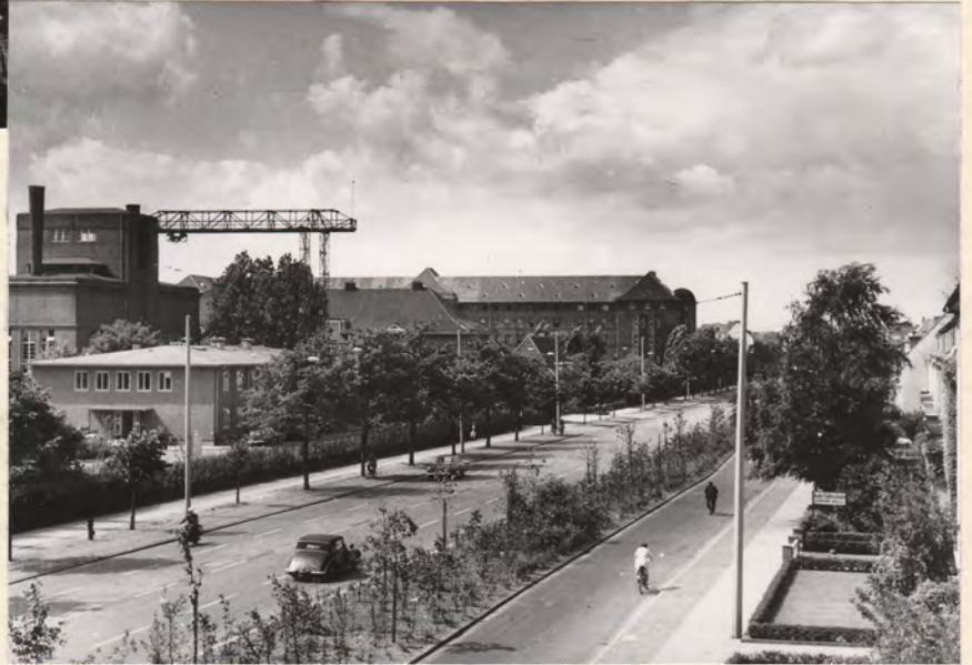
Zwischen St. Jürgenstr. u. Bennigsenstr. Fahrbahn- verbreiterung von 8,5 m auf 12 m. Gesamtbreite 30-35 m Ausbaulänge 1370 m. Granitkleinpflaster mit Verguß auf 25 cm stark. Unterbau aus Bruchsteinpacklage und Stein- schlag, teils Schüttpacklage in der Verbreiterung.
