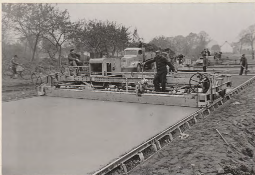
Fertiger mit Glättbohle
