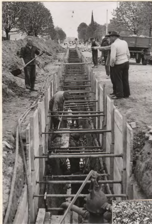
Zwischen St. Jürgenstr. u. Bennigsenstr. Fahrbahn- verbreiterung von 8,5 m auf 12 m. Gesamtbreite 30-35 m Ausbaulänge 1370 m. Granitkleinpflaster mit Verguß auf 25 cm stark. Unterbau aus Bruchsteinpacklage und Stein- schlag, teils Schüttpacklage in der Verbreiterung.
