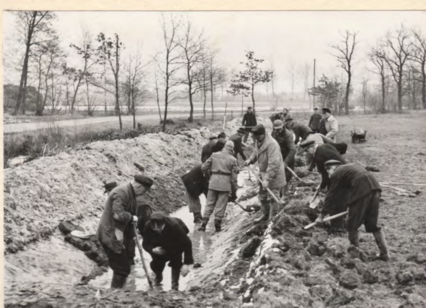
Verlegung des Str.-Graben (im Z-Programm)
