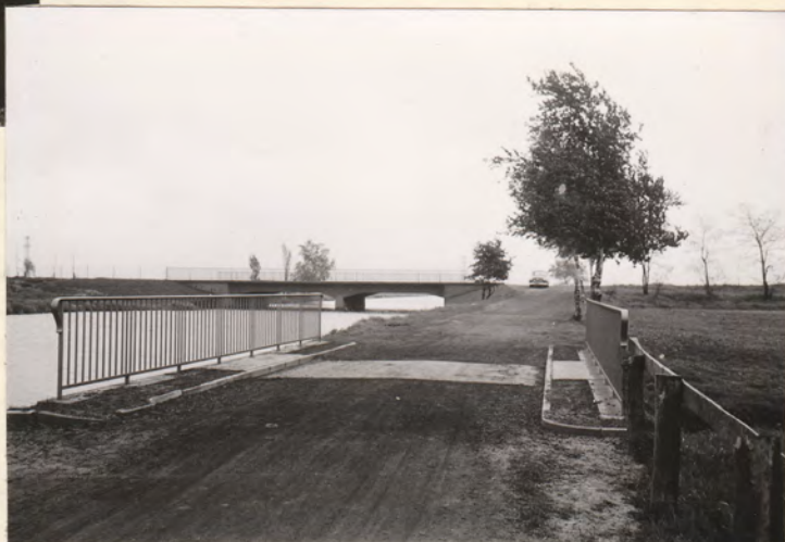
Brücke Pferdeweideweg Stützweite 2,50m Gesamtbr. 5,80m Kl. 30 Stahlbeton Kosten: DM 25700,-
