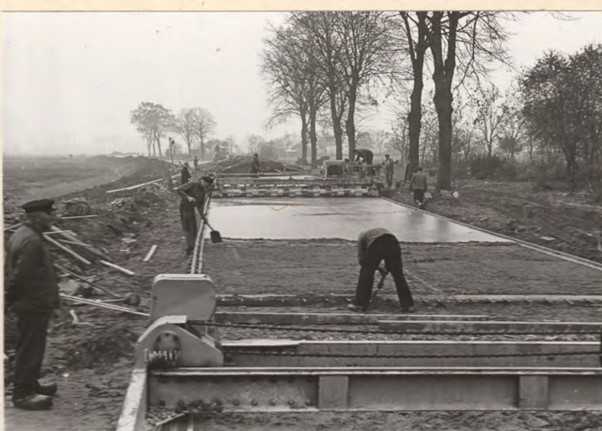
Im Vordergrund Verteiler, im Hintergrund Fertiger u. anschl. Abdeckdach
