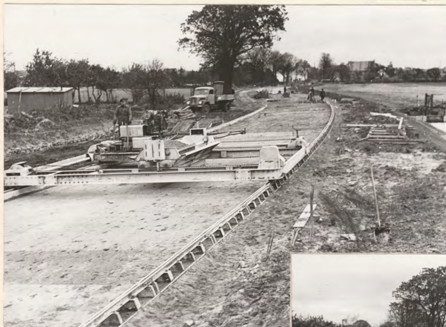
Legen der Bohlen mit Schienen und herstellen des Planums durch Verteiler
