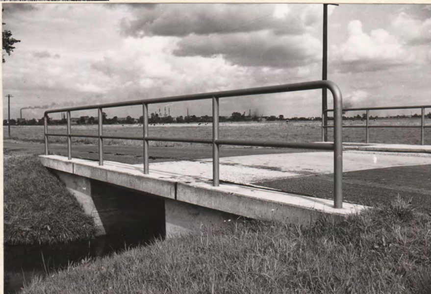
Zwei Brücken-Neubauten im Zuge der Weißefeldstr. Stützweite 4,10 m Gesamtbr 7,80m Kl. 30 Stahlbeton. Kosten: je Brücke DM 23700
