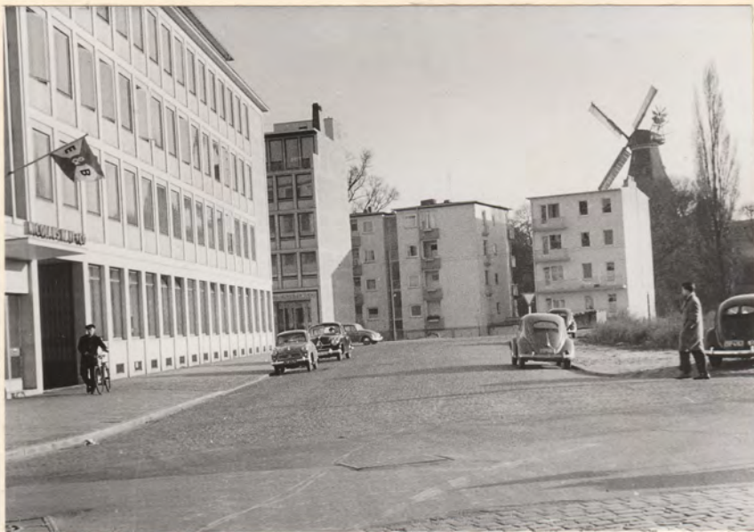
Am Wandrahm Neuanlage zwisch. Bornstr. und Bürgerm.-Smidt-Str. Fahrbahnbr. 9m. Gesamtbr. 14 m. Ausbaulänge 60 m. Granitkleinpflaster auf 25 cm stark. Unterbau aus Mauer- brocken u. Steinschlag. Fertiggest. Juli 55 · Kosten: DM 38000.-
