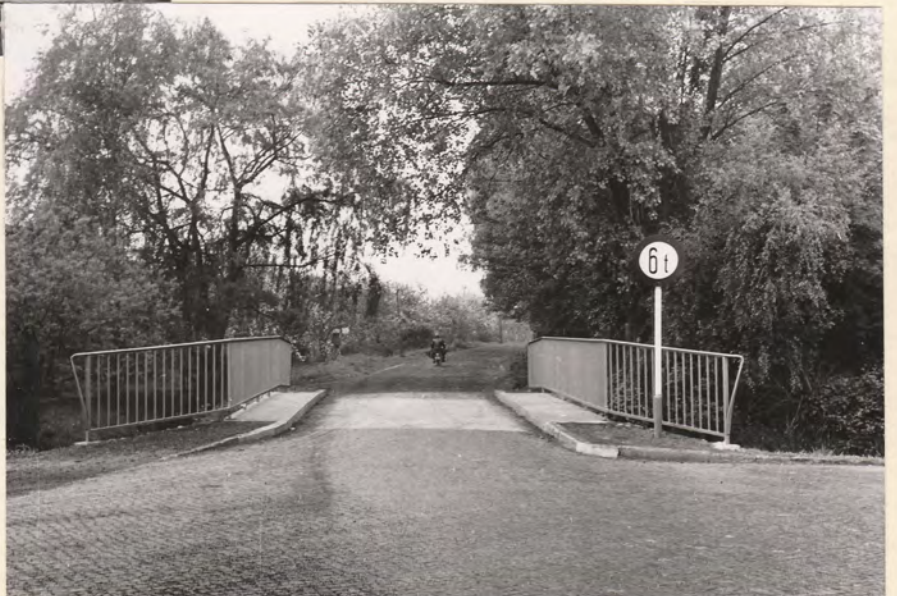
Brücke über die kl. Wümme im Zuge „Hinter der Munte“ Stützweite 3,75 u. 3,75 m Gesamtbr. 4,90 m Tragfähigkeit Kl. 30 Betonplatte auf Spundwand u. Pfählen. Kosten: DM 12500,-
