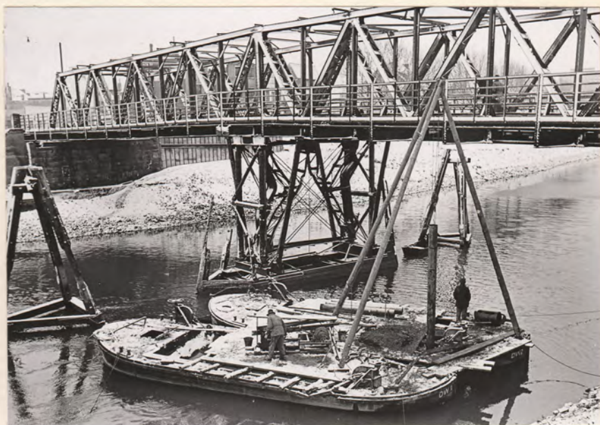
Bohrversuche an der Brautbrücke und St. Pauli-Brücke. Kosten: DM 14567,-
