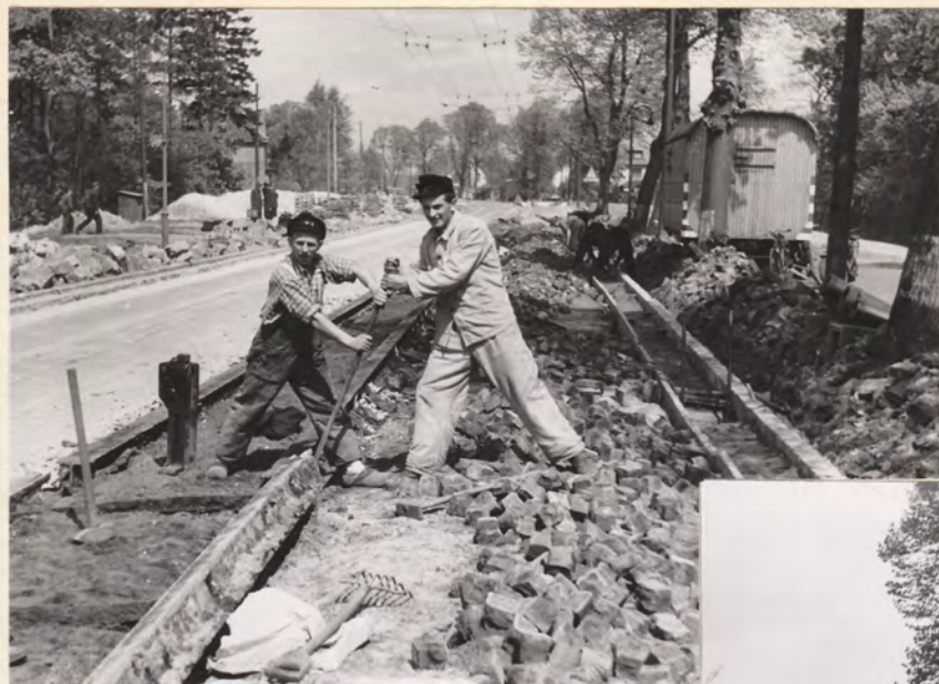
Ausbau der alten Straßenbahngleise
