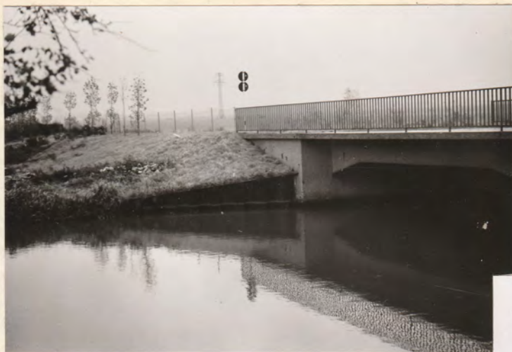
Uferbefestigung an der Brücke Ritterhu- der Heerstr. über das Maschinenfleet. Stahlpundwand. Kosten: DM 9800
