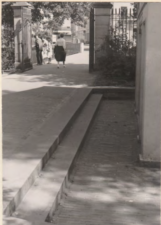
Neue Werksteinstufen am Bischofstor aus Osterwalder Sandstein Kosten:
