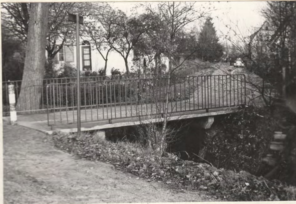
Brücke am Lehesterdeich 41 (Daniel Hilken) Stahlbetonbrücke, Stützweite 2 \times 1,30 \text{ m} , 1 \times 3,20 \text{ m} Gesamtbreite 3,20 \text{ m} . Klasse - 500 \text{ kg/m}^2 Kosten: DM 3800,-
