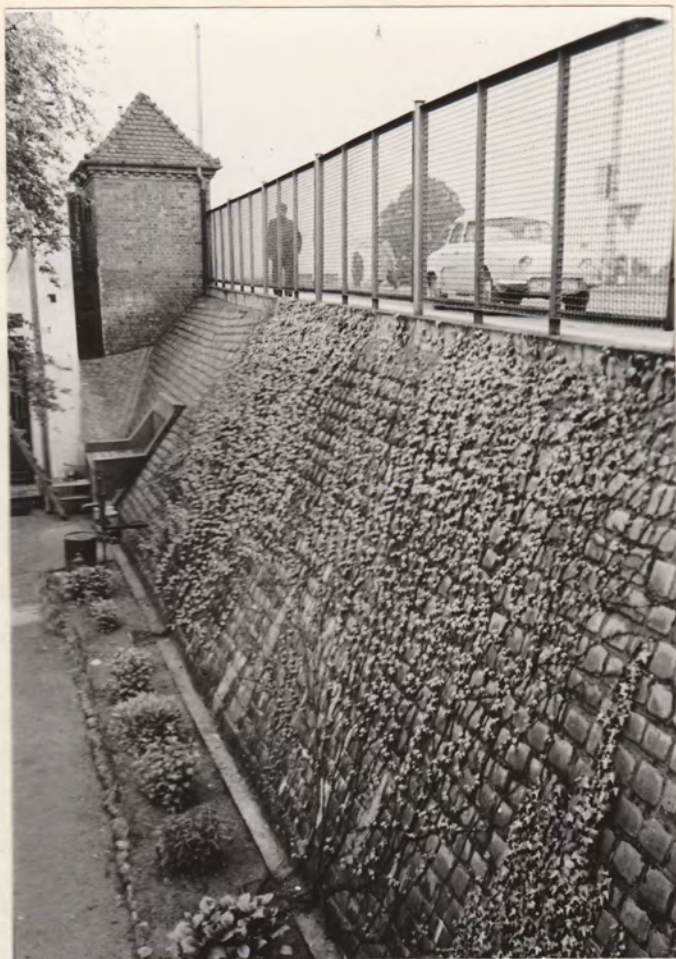
Stützmauer Fahrstraße Stahlbeton, mit Großpflaster verklei- det. Höhe ~3,20 m, Länge ~ 24,00 m Kosten: DM 11500,-
