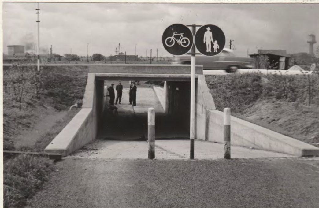
Fußgänger- und Radwegtunnel unter der Autobahn in Höhe Halmerweg Stahlbetontunnel, Stützweite 4,50 m, Klasse 60, Kosten: DM 130 000,-
