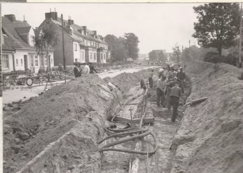
Kabel-Verlegung
