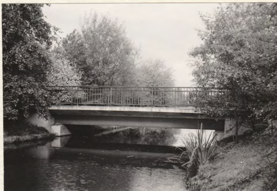
Brücke auf dem Osterholzer Friedhof (Bauwerk 299) Neubau einer Stahlbetonbrücke am Nordeingang (Hallacker) Stützweite 8,10 m. Gesamtbreite 5,40 m. Klasse 12 Kosten: DM 9900,-
