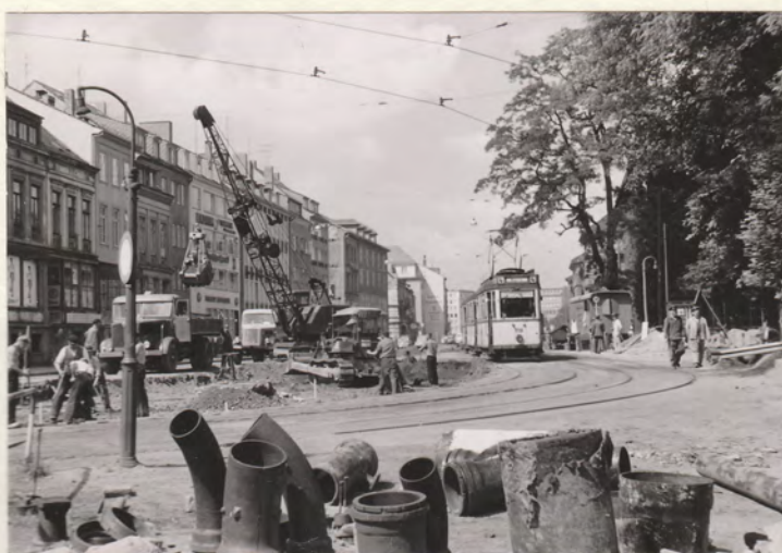
der Umbau beginnt...
