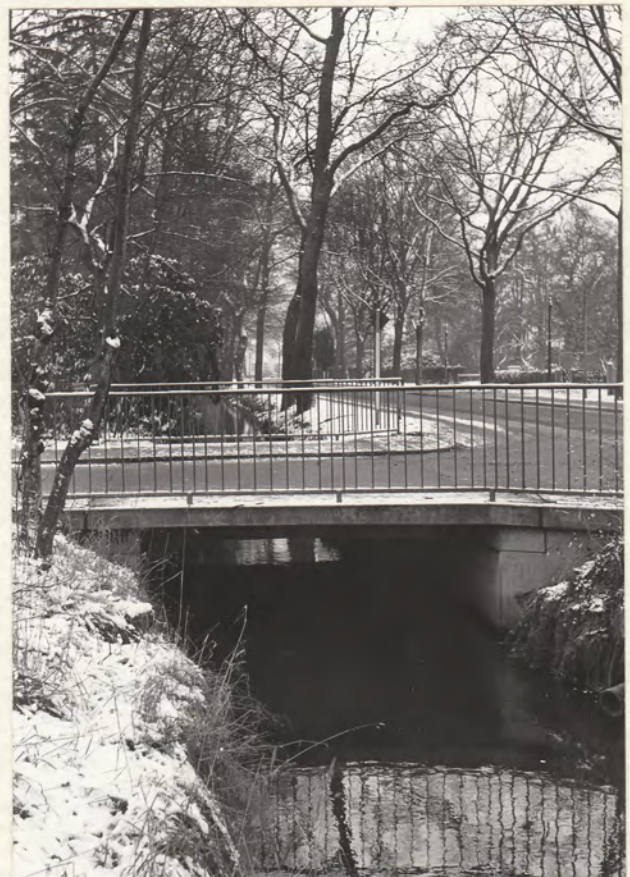
Brücke am Maßolleweg in Oberneuland Stahlbetonbrücke, Stützweite 3,45 \text{ m} Gesamtbreite 10,40 \text{ m} , Klasse 30 Kosten: DM 15 000,-
