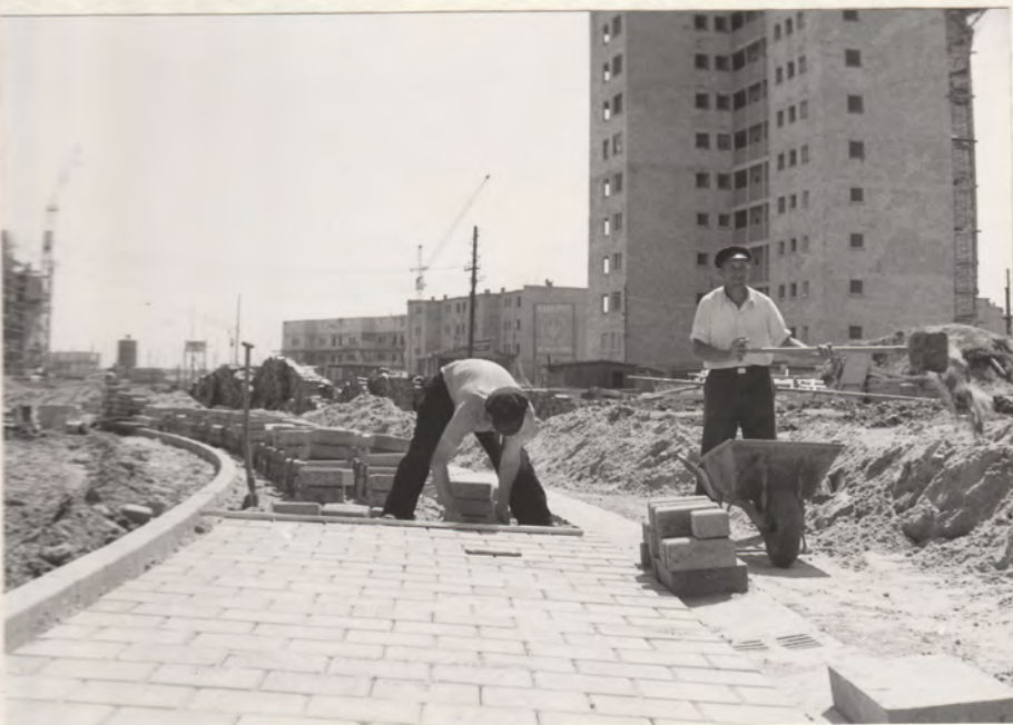
Die Parkplatzflächen wurden teils mit Betonsteinen gepflastert
