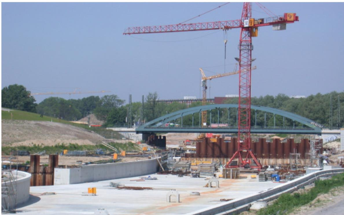
Bauabschnitt 2.1: Trogbauwerk und Eisenbahnbrücke an der neuen AS Bremen Neustadt
