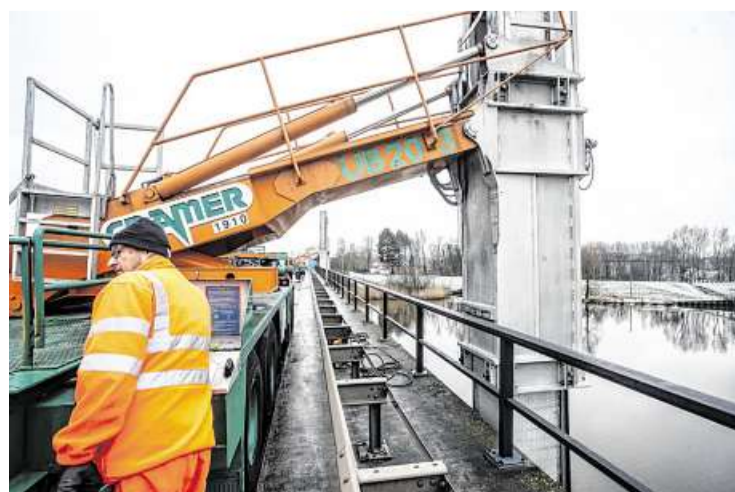
Einer der tonnenschweren Unterflursteiger auf der Brücke: Am Stahlarm hängt die Bühne, auf der die Materialprüfer mehrere Meter über der Lesum arbeiten. Die Plattform lässt sich schwenken.
