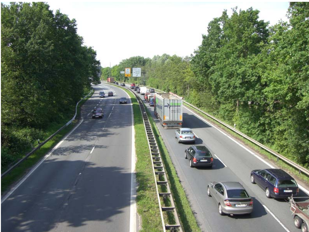
Zubringer Überseestadt Fahrtrichtung stadteinwärts (Blickrichtung Nord-West-Knoten)
