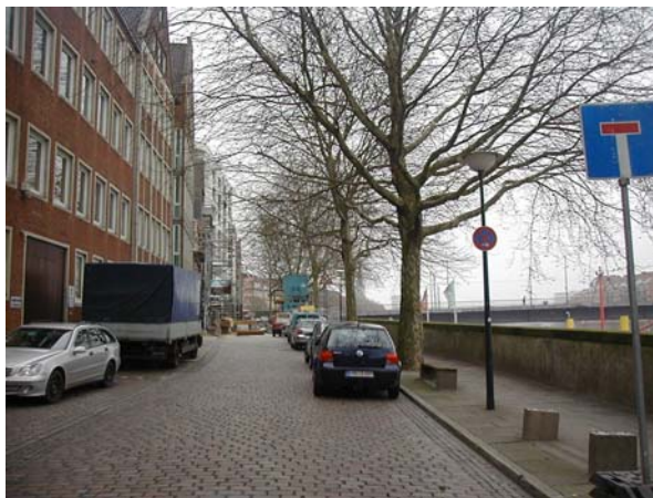
vor dem Umbau
