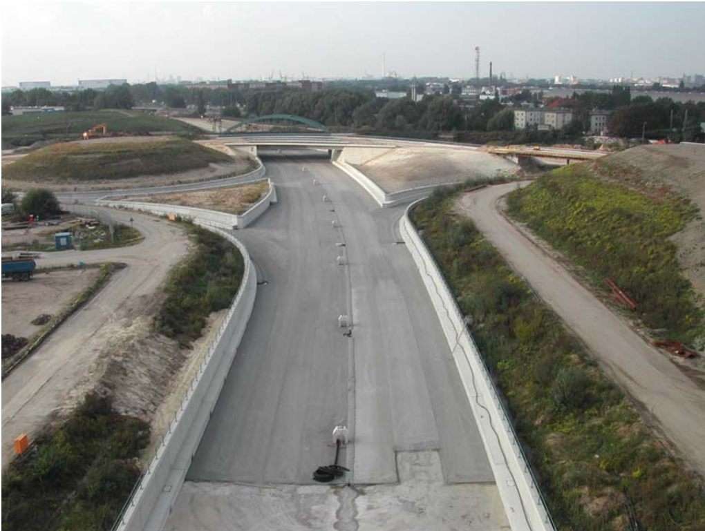
Trogbauwerk im Bereich der „AS Neustadt“
