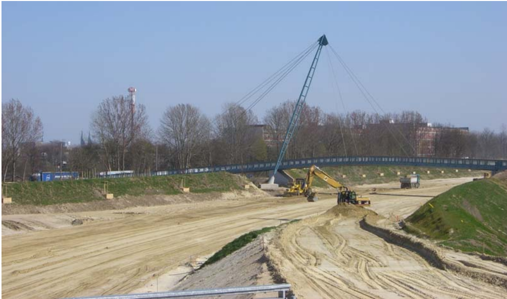
BA 3/1 Pylonbauwerk im Zuge der Visbeker Straße
